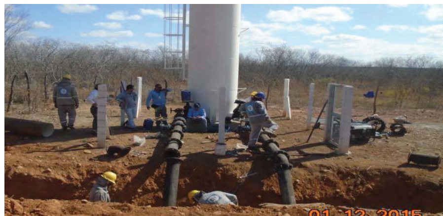
Montagem dos equipamentos hidromecânicos: obra da adutora do Alto Oeste já está 95% concluída
